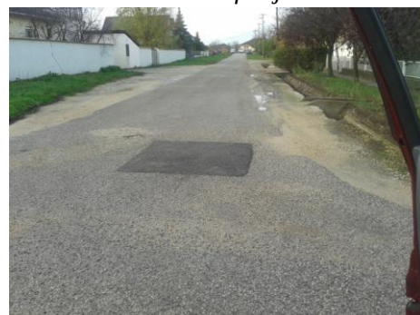
Bem J. utcai útfelújítás
