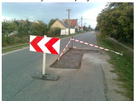
Ladányi utcai útfelújítás
